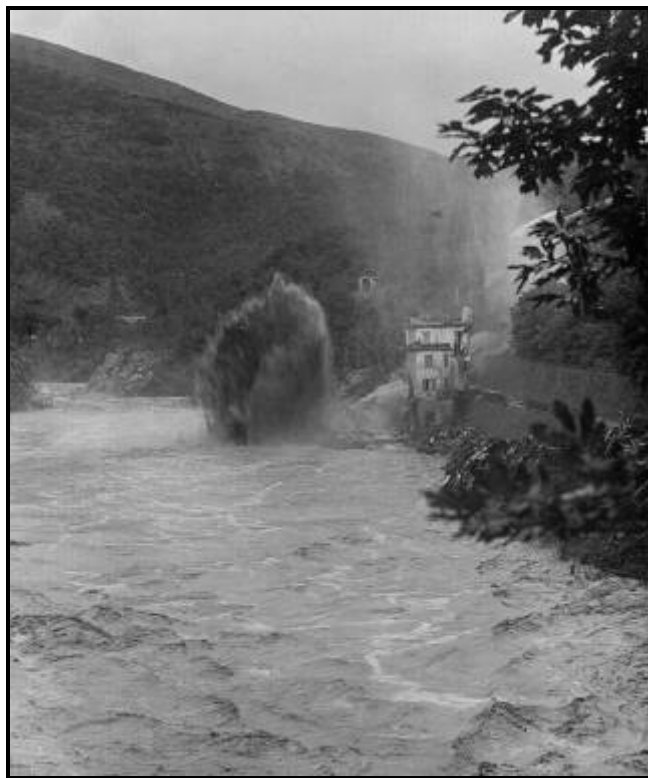
La distruzione della centrale elettrica
