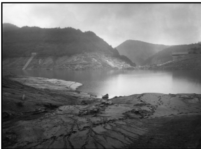
Sella Zerbino e la Diga Secondaria poche ore dopo dal disastro del 13 agosto 1935
